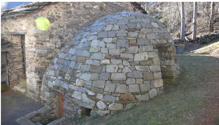
Beispiel eines zweigeschossigen Typs mit zwei separaten Eingängen
