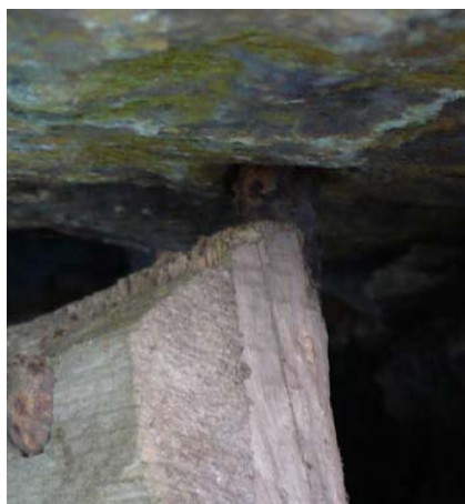
Links: Das obere Scharnier, als Eisendorn ausgebildet
