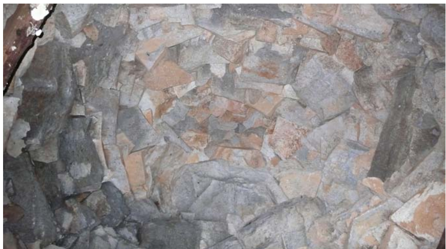
Innenansicht der Kragkuppel eines crot mit Innenabmessungen von 4,8m Durchmesser und 4,3m Höhe Foto: Christian Cortesi
