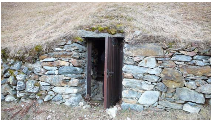
Beispiel eines in eine Terrassierungsmauer eingebauten Typs
