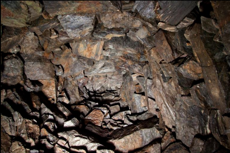
Blick in die Gewölberosette
