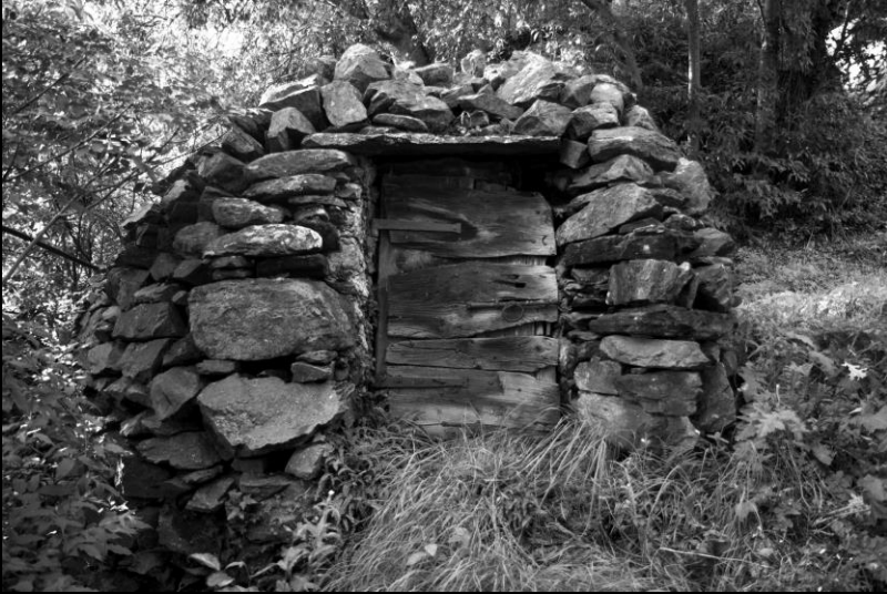
vàsca , Castelit, Bianzone, Wasserspeicher mit Schacht, Schachttiefe ab Eingang 160 cm
