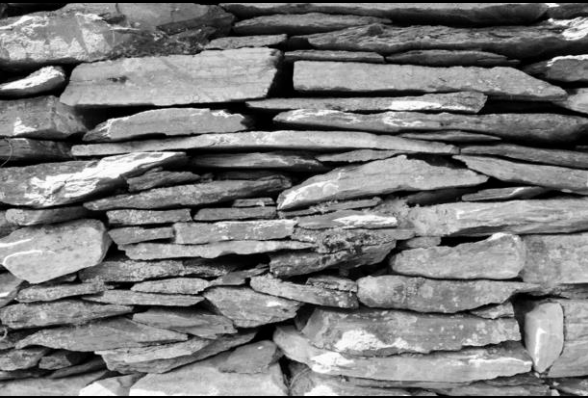
Mauer aus Bruchsteinen (Monton, Gem. Poschiavo)
