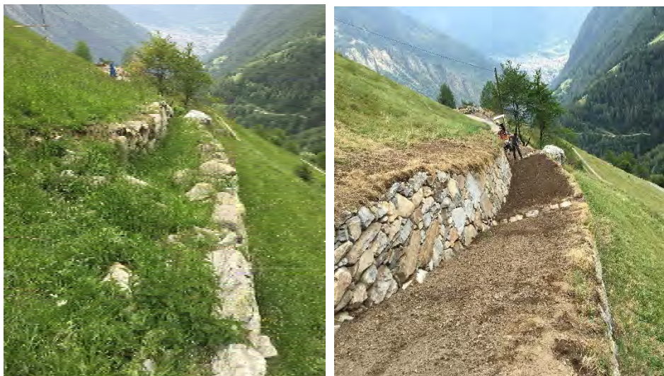
Fig. 8: A sinistra carraia tra i terrazzi completamente distrutta; a destra durante i lavori di ripristino.
