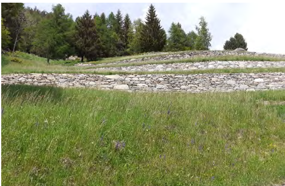
Fig. 9: Risultato dei lavori stato 2020, dopo i lavori del 2019.
