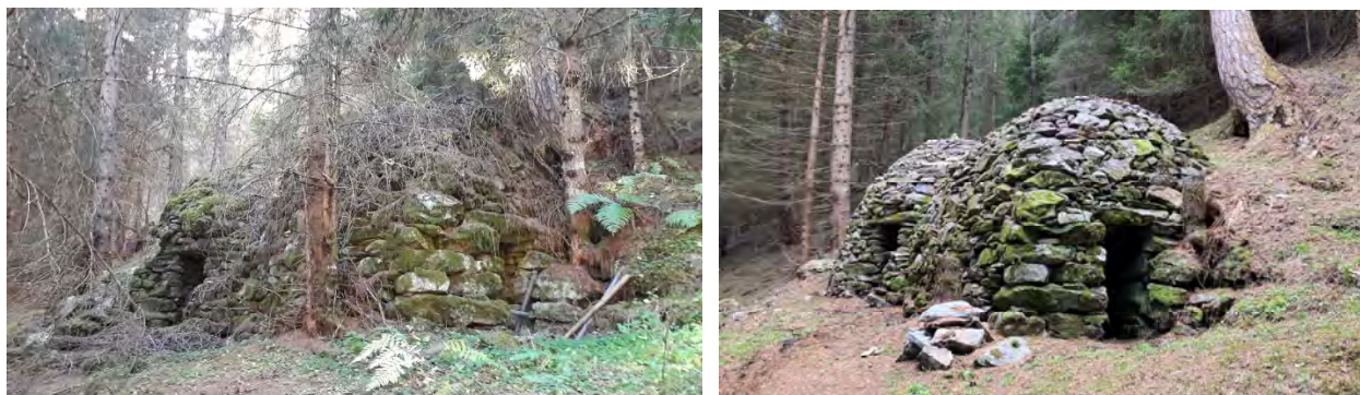
Fig. 14: Crot del Bratel prima e dopo i lavori
