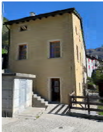
Dopo i lavori di ristrutturazione
