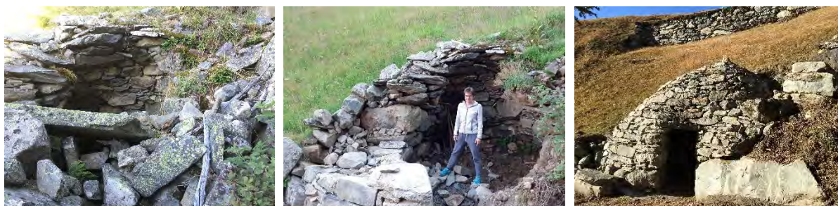
Fig. 13: Crot ai Paganin: prima, durante e dopo i lavori di ripristino
