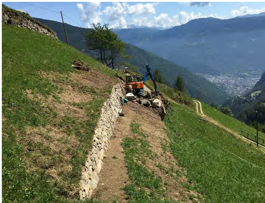
Fig. 7: Esecuzione dei lavori in condizioni di elevata ripidità del terreno da parte del consorzio Pianta - Pola
