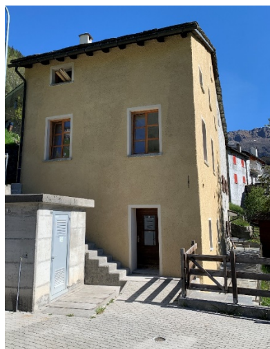
Dopo i lavori di ristrutturazione
