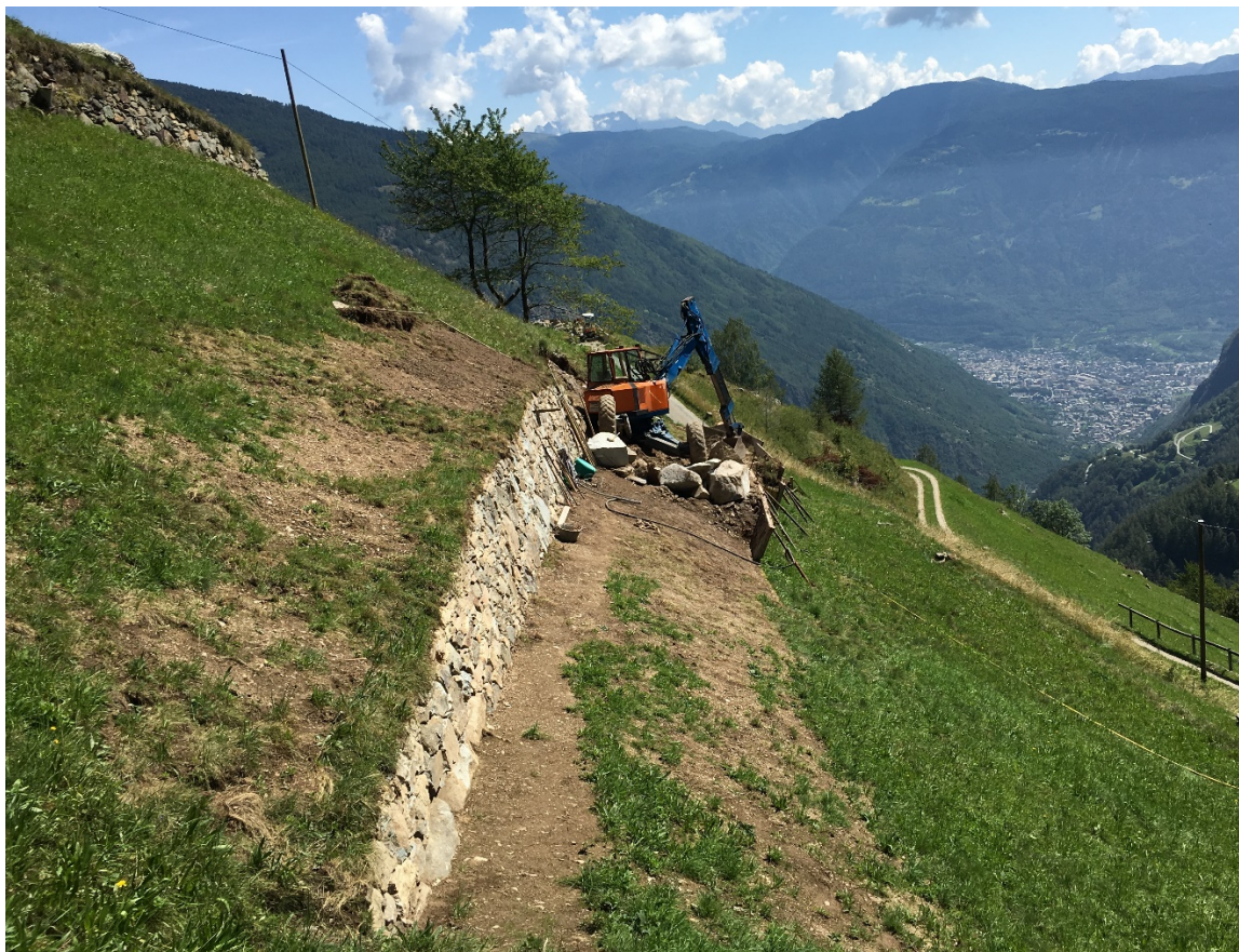
Esecuzione dei lavori in condizioni di elevata ripidità del terreno da parte del consorzio Pianta - Pola
