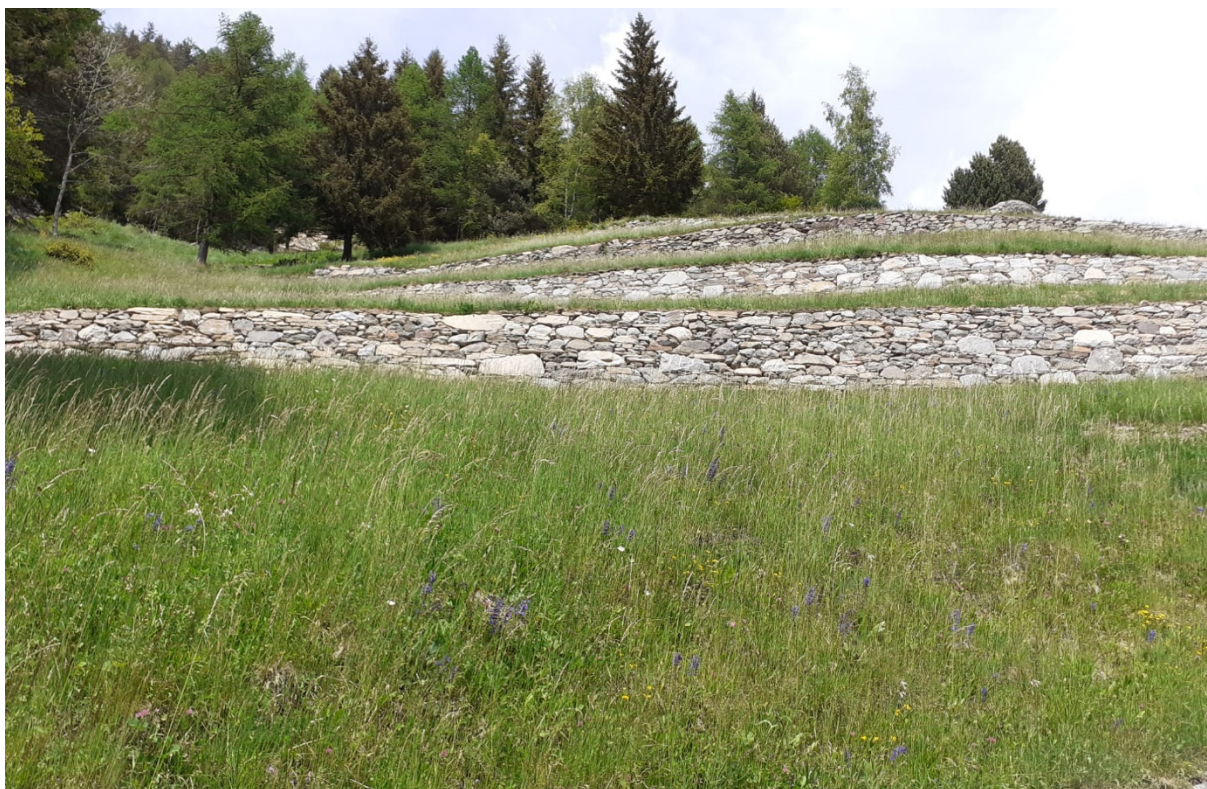
Risultato dei lavori stato 2020 dopo i lavori del 2019. Si nota la qualità dei muri e l'inerbimento completo della superficie già l'anno seguente.
