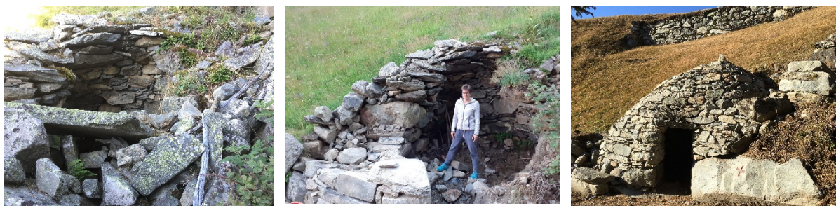
Crot ai Paganin: prima, durante e dopo i lavori di ripristino
