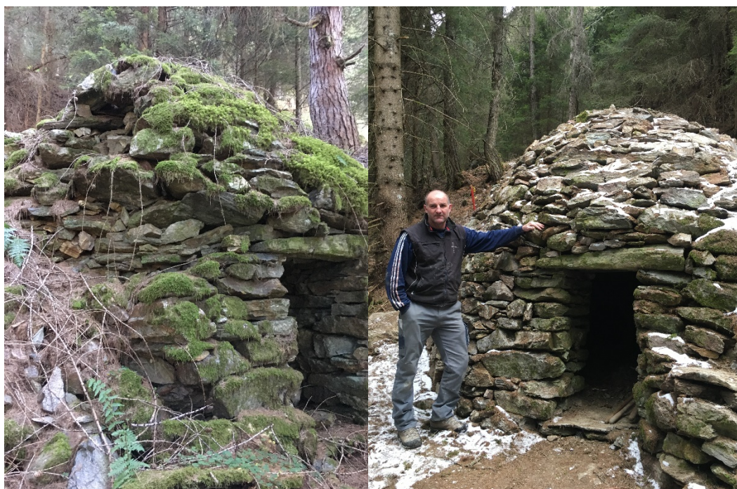
Uno dei due crot del Bratel prima e dopo i lavori con Silvano Balsarini dell'impresa Plozza Soler che ha ricostruito i crot
